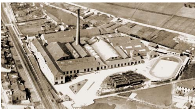
O complexo fabril da “ Fábrica de Cerâmica do Carvalhinho de Vila Nova de Gaia ” (vista aérea)
