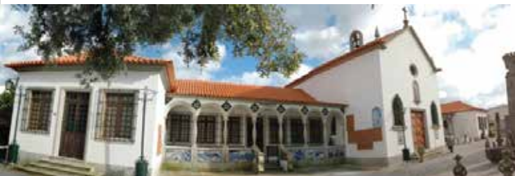
Fachada exterior do Museu de Santa Maria de Lamas Estrutura arquitectónica remontante às décadas de 50 e 60 do séc. XX.
